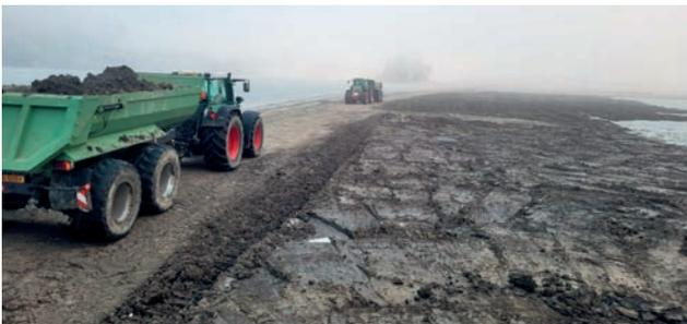
Im Sommer 2024 wurden, gemäss generellem Projekt, Sickerschlitze zur Unterstützung des Wasserhaushalts erstellt. Die Ausführung erfolgte in Rücksprache mit der Melioration. Damit wurden punktuelle Vernässungen (u.a. im Bereich von kleinräumigen Geländeunebenheiten) behoben.
