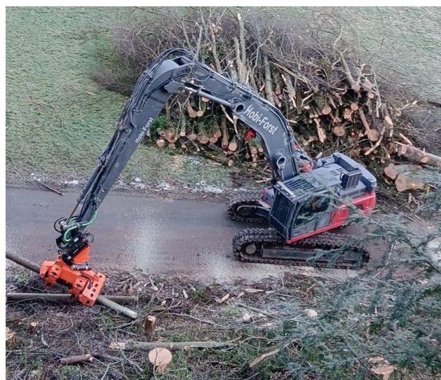
Der Langarmbagger aus Valens im Einsatz zwischen Kobelwald und Freienbach.
