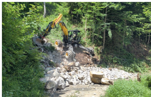
Der Schreitbagger von der nahen Baustelle bohrte Löcher für die Sprengsätze ins Gestein und schaufelte danach das Material talwärts.
